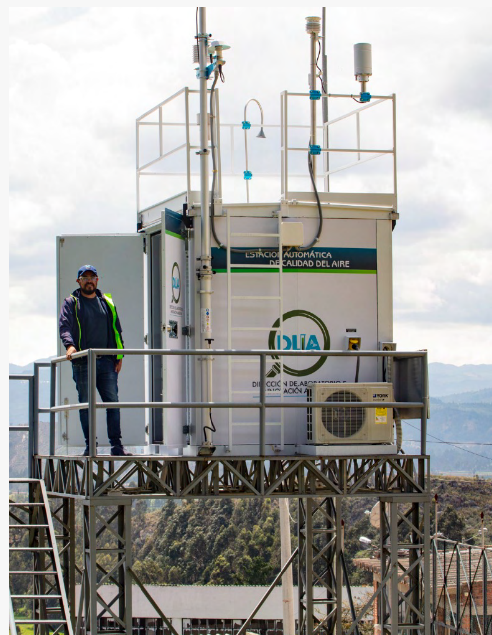
Calidad del aire, Red de monitoreo, Estaciones automatizadas - www.car.gov.co
