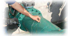
MEDICIONES DE ESPESORES DE PINTURA
